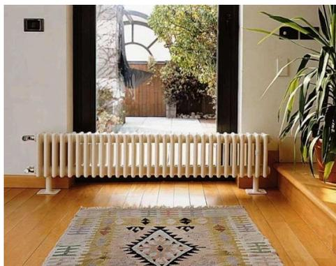
Благодаря малой ширине прибора (до 474 мм) изделия можно размещать в узких простенках рядом со строительными проемами полного профиля. Кроме того, вертикальные батареи иногда устанавливают как отдельный элемент интерьера (напольным способом, с применением кронштейнов разной конструкции). Для сочетания дизайна помещения и оформления радиатора существует возможность выбора цвета корпуса радиатора – производится окрашивание в различные цвета универсальной шкалы RAL.
