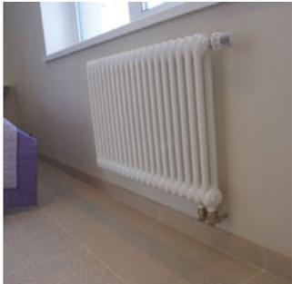
Нижняя подводка к радиатору отопления позволяет максимально скрыть коммуникации. Присоединение трубопроводов осуществляется к специальным нижним резьбам с помощью узлов прямой или угловой формы. Регулирование температуры устройства производится в автоматическом режиме с помощью встроенного термостатического клапана. Установка радиаторов производится настенным или напольным способом.
