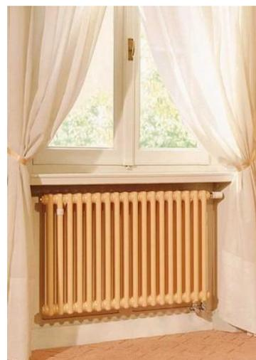
Нижняя подводка к радиатору отопления позволяет максимально скрыть трубопроводы подсоединения. Подключение коммуникаций производится к специальным резьбам диаметром 15 мм, расположенным на нижнем срезе стальной батареи с межосевым расстоянием 50 мм. Чаще всего подключение осуществляется с помощью специальных узлов – прямых или угловых, регулирование температуры производится встроенным термовентилем.
