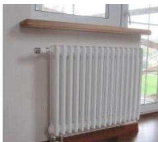
Боковое подключение радиаторов отопления имеет увеличенное сечение (20мм) – это улучшает качество циркуляции теплоносителя и обеспечивает необходимый нормативный расход. Изделия из стали предназначены для работы в системах водяного отопления закрытого типа со следующими параметрами:
