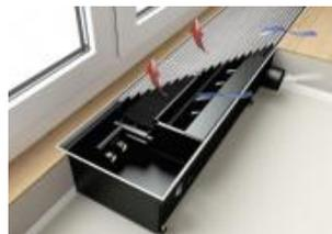
**Внутрипольный конвектор с естественной конвекцией с подводом воздуха Ascotherm eco KRN92 1250x310x110**
